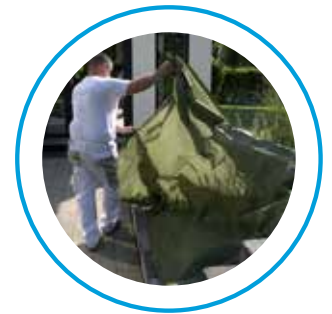
Angrenzende Pflanzen werden immer abgedeckt.
